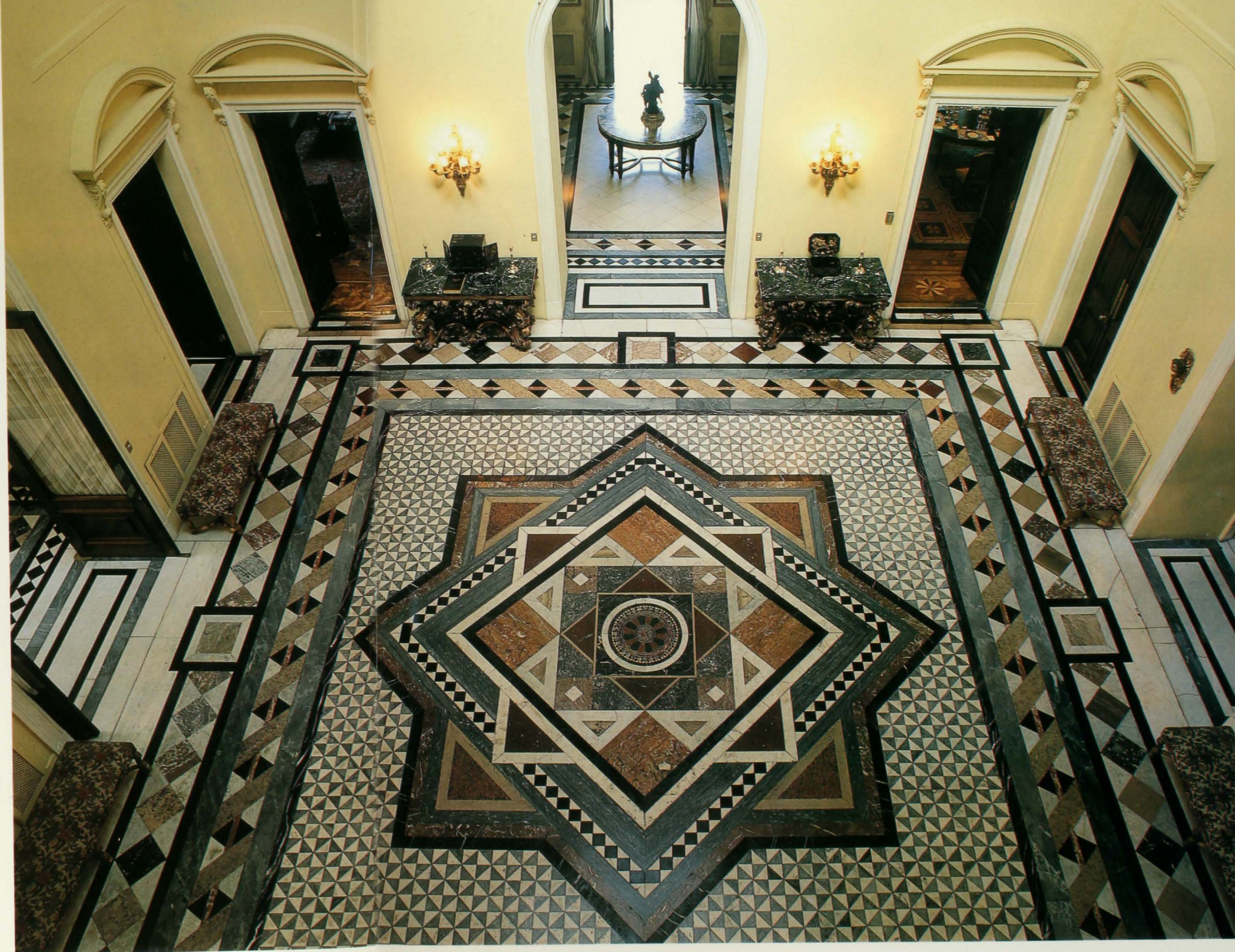
“Hall de Entrada, donde se destaca el piso original del siglo XIX, en mosaico de mármol policromado italiano”.
